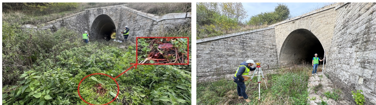
Рисунок 7 — Нівелювання споруди
