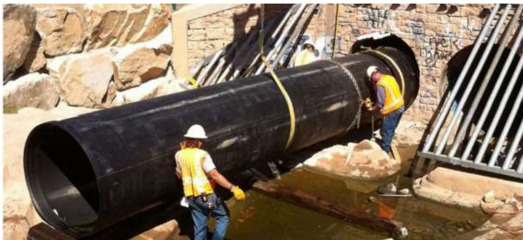
Рисунок 2—Відновлення дорожньої водопропускної труби ковзанням Джерело: на підставі [30]
