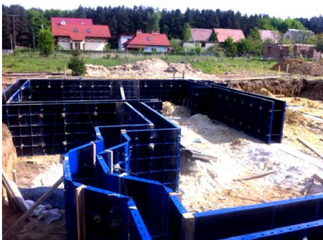
Рисунок 1 – Загальний вигляд вертикальної опалубки для зведення будівель монолітного типу Джерело розроблене авторами
