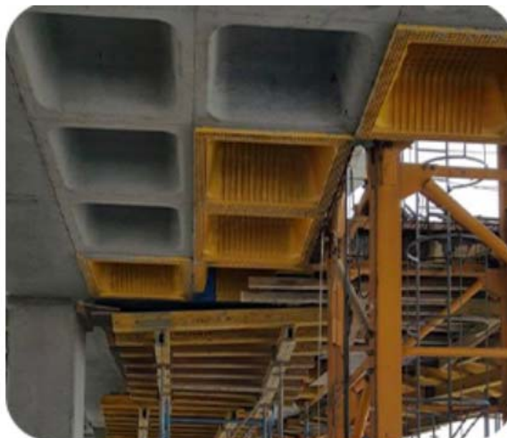
Рисунок 4 – Загальний вигляд кесонного перекриття
