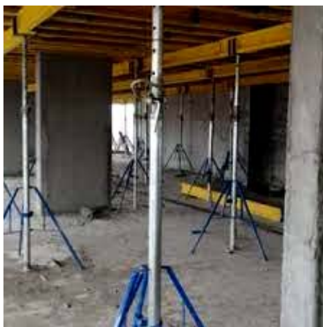
Рисунок 2 - Загальний вигляд горизонтальної опалубки для бетонування монолітного перекриття на телескопічних тріногах Джерело розроблене авторами
