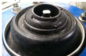
Рисунок 1 – Опори з пошкодженим гумовим елементом
