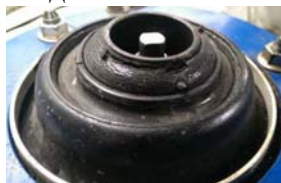
Рисунок 1 – Опори з пошкодженим гумовим елементом
